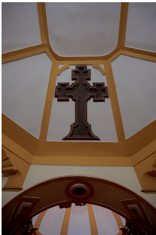
Fig. 3. Detalle de la cubierta de la ermita del Cristo del Calvario de Pinto.
